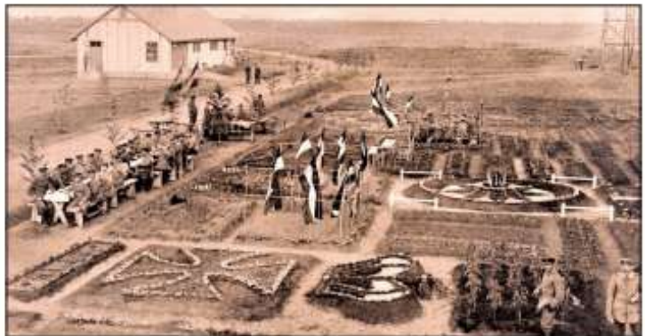
Kameraden auf der Feier anlässlich der Einweihung der Außenanlagen rund um die Luftschiffhalle
