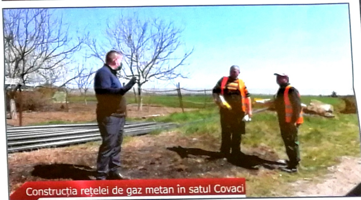
Construcția rețelei de gaz metan în satul Covaci
