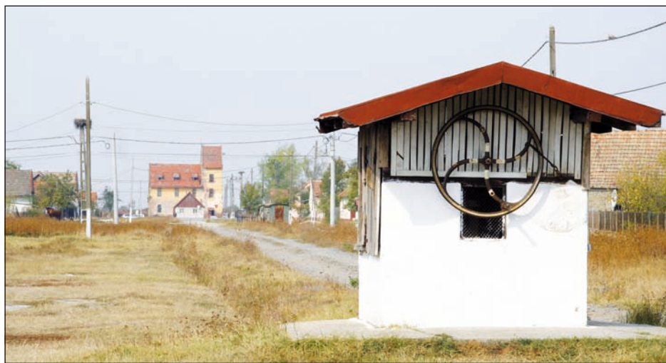
In Nitzkydorf gits noch Dorfbrunne seit der Ansiedlung der dortiche Hecke-schwowe. Mer hat selmols 30 bis 40 Meter tief grawe misse, bis mer uf gutes Trinkwasser gtosst is. Die Brunne sin ausgemauert, mit eem Brunnehaus, des wu de Wellbaam traat, ingfasst. Der Wellbaam beweht die Kett mit de zwaa Holzeemre (sie fasse je 20 Liter Wasser) an jedem End – de volle Eemer kummt ruf, de leere Eemer geht runerzus. (ha) Bilder: Zoltán Pázmány
