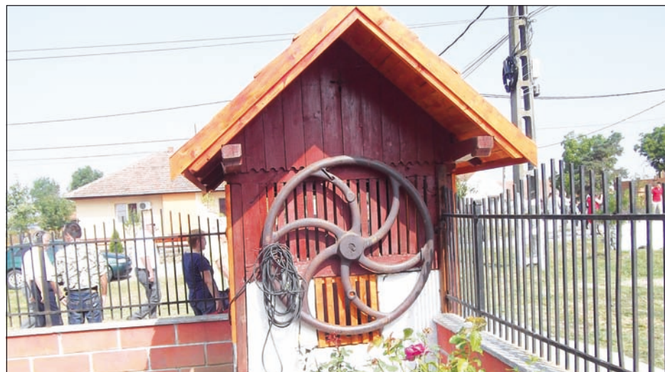
In Nitzkydorf gits noch Dorfbrunne seit der Ansiedlung der dortiche Hecke-schwowe. Mer hat selmols 30 bis 40 Meter tief grawe misse, bis mer uf gutes Trinkwasser gtosst is. Die Brunne sin ausgemauert, mit eem Brunnehaus, des wu de Wellbaam traat, ingfasst. Der Wellbaam beweht die Kett mit de zwaa Holzeemre (sie fasse je 20 Liter Wasser) an jedem End – de volle Eemer kummt ruf, de leere Eemer geht runerzus. (ha) Bilder: Zoltán Pázmány
